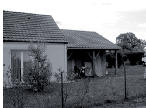
Extension auto construite - Thenay
